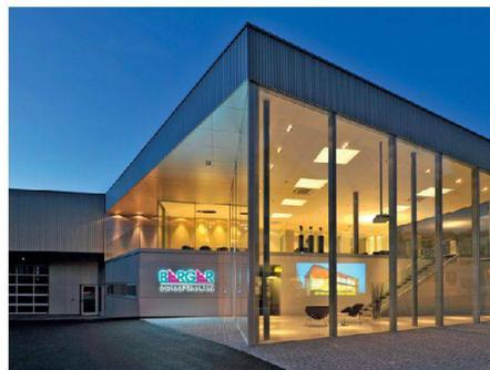
Die Filigranverglasung «swiss Fine Line» erfüllt hohe Ansprüche bezüglich exklusiven Architekturdesigns. Die Rahmenprofile werden umlaufend in Boden, Decke und Seitenwände eingearbeitet, wodurch fließende Grenzen zwischen Innen und Aussen entstehen.
