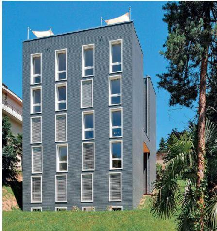
**01 Wohnhaus Casa Montarina, Lugano.** Der sechsgeschossige Bau ist komplett aus Holz konstruiert. Der Grundriss misst 12.4 x 12.4 m, die Gesamthöhe knapp 18 m
