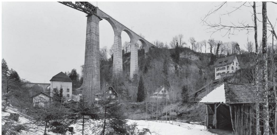
01 Sitterviadukt der Südostbahn, 1910, von Rudolf Weber und Alexander Acatos (Ingenieure), Fritz Ackermann (Stahlbau) und Richard Coray (Gerüstbau). Vorne rechts: Kubelbrücke, 1780, eine der letzten erhaltenen Brücken von Hans Ulrich Grubenmann (Foto: Martin Linsi)
