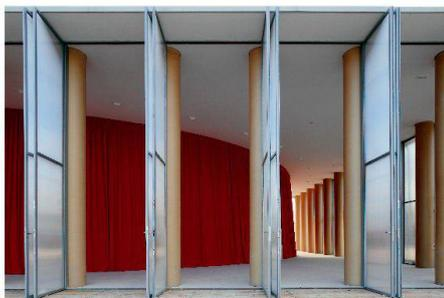
04–05 Eine «Säulenreihe» aus Kartonrohren ( $\varnothing=60$  cm, h=595 cm) umfasst den temporären Konzertsaal in L'Aquila, dessen Wand zur Schalldämmung aus Sandsäcken besteht (Fotos: Fabio Mantovani)
