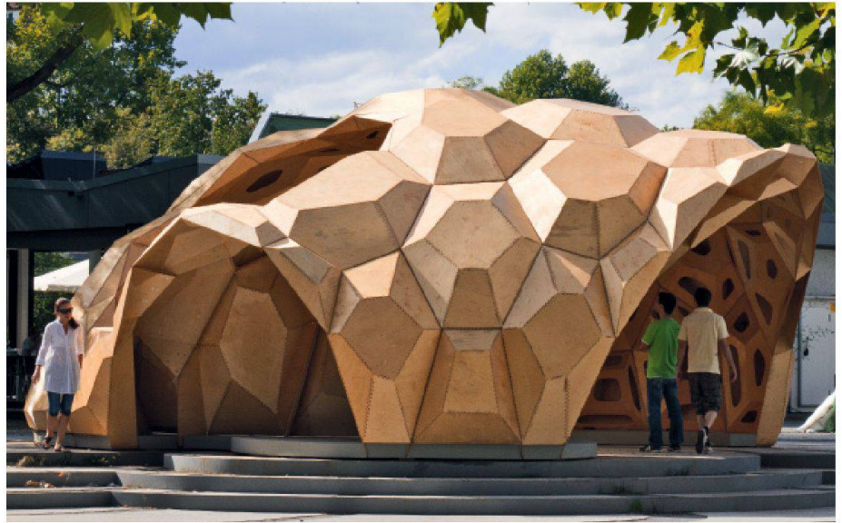
01 Die Struktur des Pavillons entspricht den mechanischen Beanspruchungen. Im Zentrum mit kleiner Krümmung sind die Kassetten über 2 m gross, während sie zum Rand hin teilweise nur 0.5 m gross sind (Fotos: Projektteam)
