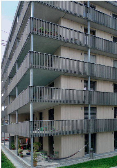
01 Mehrgeschossiger Holzbau (Foto: www.hausbaumesse.ch)
