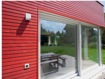
Bei der Hebeschiebetüre «Maxima» von Wenger wird der Wärmeverlust in den kritischen Zonen stark gesenkt, und die Oberflächentemperaturen werden erhöht. Beim unteren Festteil konnte der Uf-Wert des Rahmens von 2.0 W/m<sup>2</sup>K auf 0.95 W/m<sup>2</sup>K vermindert werden. Die Oberflächentemperaturen konnten bei der Rahmenpartie und der Mittelzone um 25% erhöht werden. Durch diese Verbesserungen liegen die Temperaturen bei einem Normalklima deutlich ausserhalb der Schimmelpilzzone.
