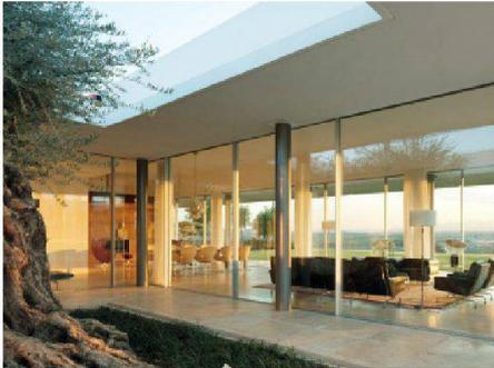
«SwissFineLine» ist ein Verglasungssystem für grossflächige Schiebefenster, das fließende Grenzen zwischen innen und aussen erlaubt. Das Wärmedämmglas als selbsttragendes Strukturelement der Glasfront ermöglicht eine rahmenfreie Erscheinung und Schlichtheit. Die Fenster sind schwellenfrei mit im Boden versenkten Laufschienen und umlaufend in Wand und Decke unsichtbar eingelassenen Rahmen montiert. Sie werden in vollisolierter, thermisch getrennter Ausführung hergestellt.
