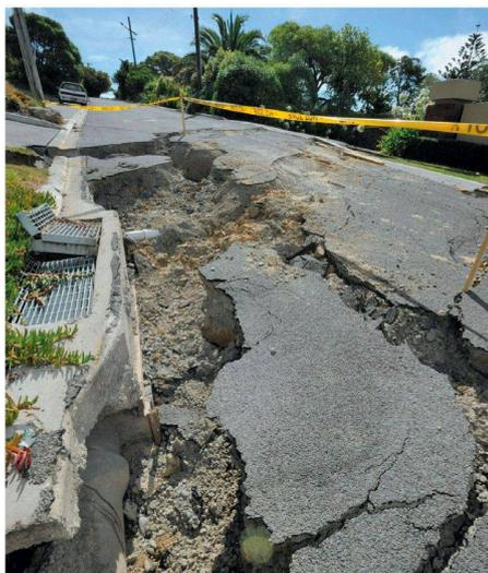
**01** In der Sumner Road bei Christchurch ist das Phänomen der Bodenverflüssigung deutlich erkennbar: Sand und Silt verflüssigten sich unter den vom Erdbeben hervorgerufenen Boderschütterungen. Der Boden an leichter Hanglage fliesst talwärts und reisst die Strassendecke auf (Foto: KEYSTONE/MAXPPP/\*)
