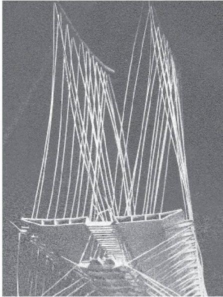
**02 Modellquerschnitt des aus zwei vierzelligen Hohlkastenträgern bestehenden Fahrbahnträgers mit darunter aufgehängtem Eisenbahntrasse; der Fahrbahnträger ist zwischen den oberen Tragseilen und den unten angeordneten Stabilisierungsseilen eingespannt**
