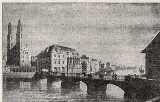
Münsterbrücke erbaut 1835—1838 Bogen zu 49 Fuss Spannweite
