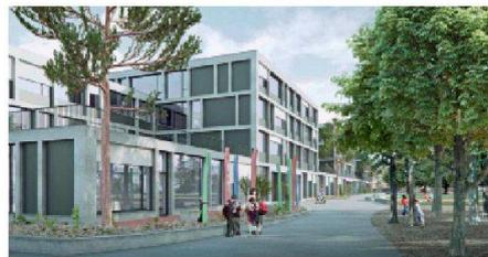
**07 «Gartenhöfe»** (werk1): Die heterogene, ein- bis viergeschossige Struktur orientiert sich an der Bebauung des nahen Gewerbegebiets. Die versetzten Volumen erzeugen in den Obergeschossen eine mäanderförmige Erschliessung
