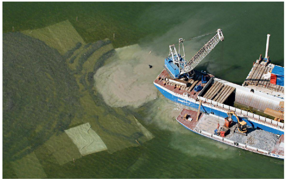
02 Rapperswil Jona – Technikum 2011: Luftaufnahme der Fundstelle während des Einbringens des Geotextils und der darüberliegenden Kiesschüttung als Schutzmassnahme (Foto: Kantonsarchäologie Zürich)
