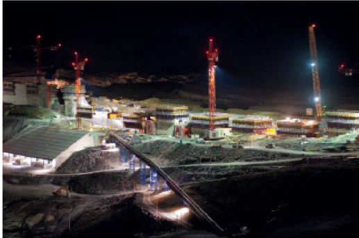
Auch nachts wurde im vergangenen Sommer an der neuen Staumauer Muttsee des Pumpspeicherwerks Linthal 2015 gebaut. (Foto: Rudolf Müller)
