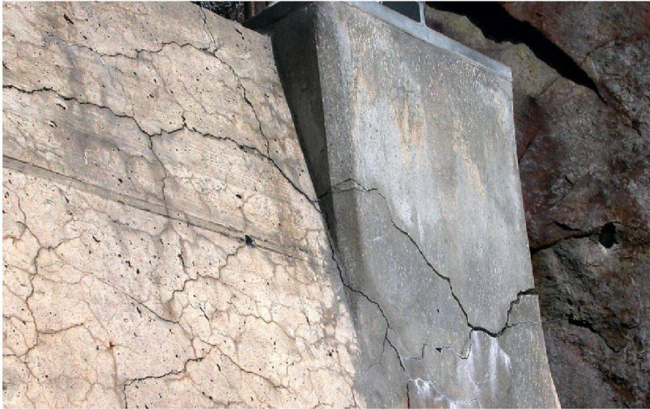
**01** Typische Betonschäden infolge Alkali-Aggregat-Reaktion mit Rissöffnungen im Millimeter- bis Zentimeterbereich. (Foto: Christine Merz)
