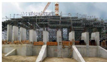
(Abwicklung der Freiform in planare Streifen) für die drei Lagen Dreischichtplatten mit einer Statiksoftware berechnet und anschliessend für den Roboterabbund der teils einachsig vorgekrümmt verklebten Platten im Werk aufbereitet (ca. 3 x 12 m<sup>2</sup> je Element, über 700 Elemente). Alle Arbeitsschritte werden derzeit an einem 1:1-Modell überprüft. Die Fertigstellung des Baus ist für das Frühjahr 2014 geplant.
