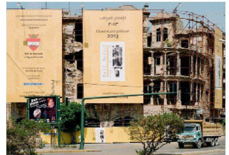
02 Beit Barakat, bis 2015 Umbau zum Kulturzentrum und Stadtmuseum
