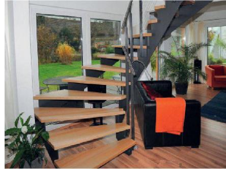
Am Stand der Firma Keller ist unter anderem eine Treppe mit herausragenden Stufen aus gebürstetem und geöltem Lärchenholz, mit Handlauf aus Lärche und Edelstahlgeländer zu sehen. Weiter ist die «Oeko-Trend», eine freitragende Treppe aus parkettverleimtem Buchenholz mit Edelstahlsprossen ausgestellt. «Loft» ist eine Treppe, die in jede modern gestaltete Umgebung passt. Die Wangen sind aus Vollkernplatten, die Stufen sowie der Handlauf aus geöltem amerikanischem Kirschbaumholz.
