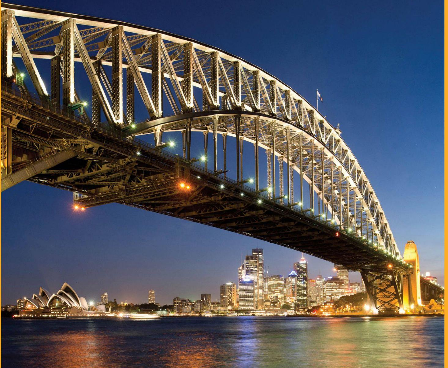
Nach 80 Jahren Dauerbelastung wurde die Fahrbahndecke der Sydney Harbour Bridge undicht. Die Stahlstruktur begann zu korrodieren und die Konstruktion drohte instabil zu werden. Innerhalb von nur zwei Wochenenden wurden 10.000 m<sup>2</sup> Oberfläche saniert und die Lebensader von Sydney für die kommenden Jahrzehnte wieder fit gemacht. Dank neuester Sika Technologien sind wir in der Lage bestehende Infrastrukturbauten ohne wesentliche Nutzungsunterbrechung nachhaltig zu erneuern.
