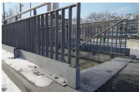
**05–06** Die Objekte mit dem grössten Schadenrisiko müssen mit Objektschutzmassnahmen nachgerüstet werden. Im Bild: Abschirmung einer Siedlung durch Mauerelement mit Einlassschiene für Dammbalkensystem (oben) bzw. Abdichtung eines Treppenabgangs mit Blech-aufsatz (unten). (Fotos: Amt für Städtebau)
