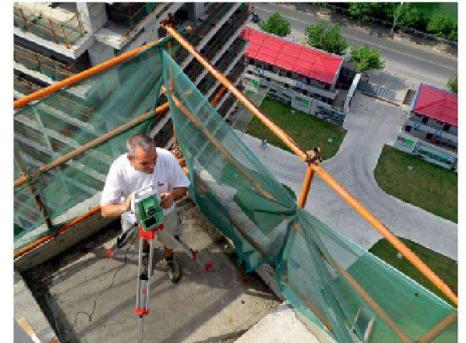
Die beiden Techniker der HMQ AG dokumentierten in Form von CAD-Daten alle Punkte, mit denen nun Krapf die komplette Gebäudehülle plant. Und sie erstellten ein millimetergenaues Fixpunktnetz über die ganze Baustelle. Dieses Netz ermöglicht die aktuellen Gebäudeaufnahmen, aber auch spätere Aufnahmen und Absteckungen mit höchster Präzision. So können bei Montagebeginn die Bezugsachsen und Bezugspunkte für die Montageequipe der Krapf AG mittels Metallplaketten markiert werden.
