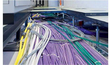
Installationsboden nachzurüsten. Doppelböden von Lenzlinger schaffen mehr Raum, erhöhen Flexibilität, Ästhetik und Sicherheit am Arbeitsplatz. Unterschiedlichen Anforderungen werden durch ein modulares System mit verschiedenen Platten, variierenden Unterkonstruktionen und mit dem Einsatz verschiedener Beläge abgedeckt. Als Schweizer Marktleader für Systemböden bietet Lenzlinger die Lösungen und das Know-how für deren Installation.
