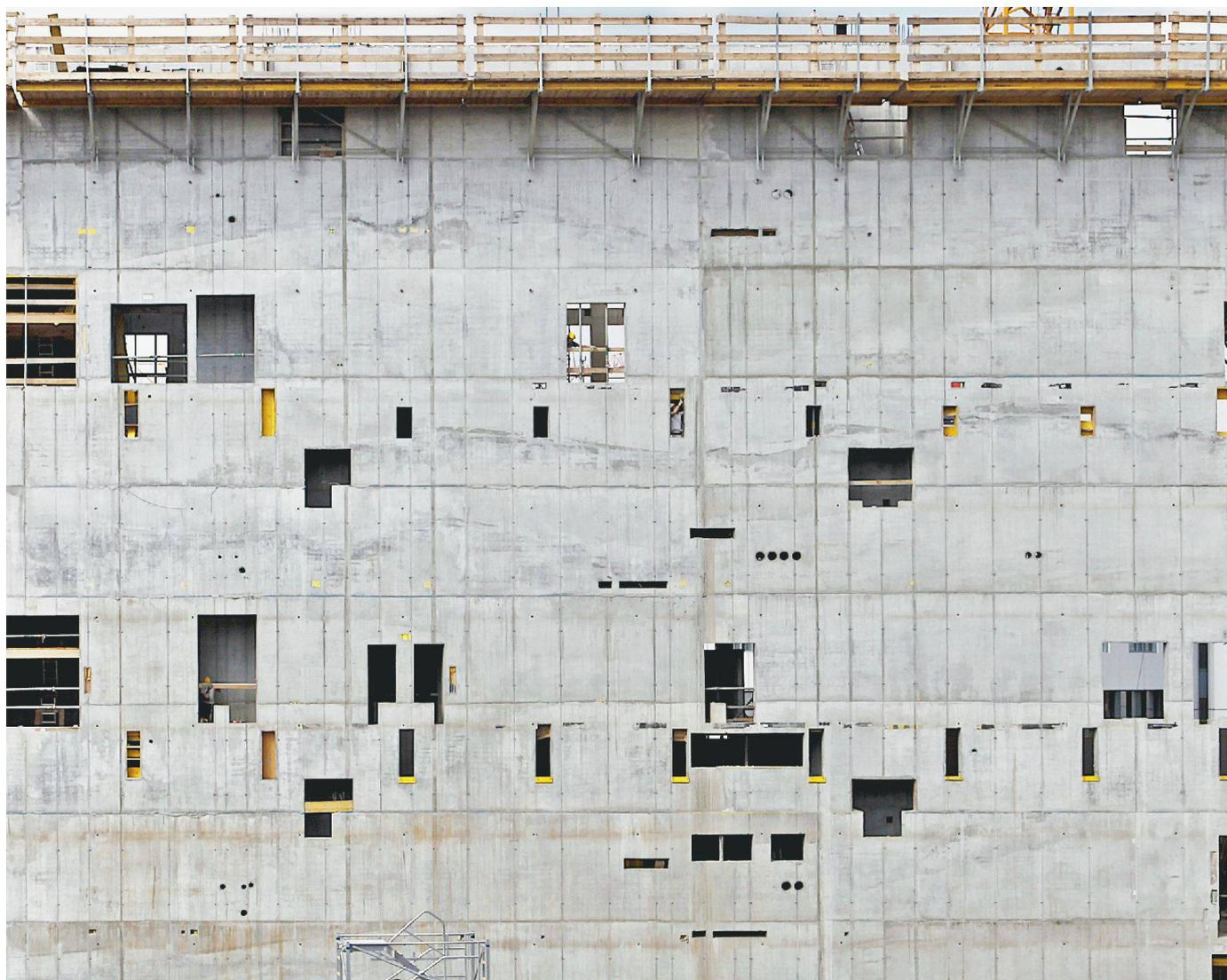
Die hallenseitigen Wände sind stark durch Türöffnungen, Aussparungen, Auflagernischen für Betonpfetten und Schalungseinlagen perforiert. Sie steifen die Hallenlängsrichtung trotz ihrer Grösse deshalb nicht genügend aus – diese Tragfunktion übernehmen die parallel verlaufenden Wände in den Treppenhäusern bzw. entlang der Fassade, die deutlich weniger perforiert sind.
