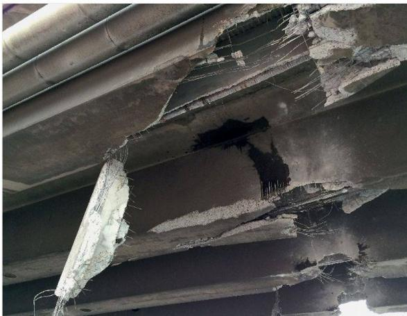
Der Ausleger zerschneidet die Hohlkastenträger. Die Hüllrohre mit den Vorspannkabeln wurden freigelegt, aber nicht verletzt.
