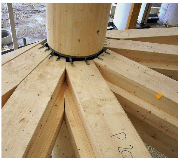
Neue Holzbau AG: Träger an einem Stützenknoten auf der Baustelle der Lodge.
