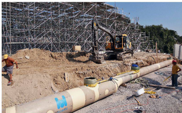
Verlegung der Lüftungsröhren von Hobas.
