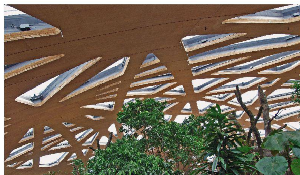
Der Ringbalken aus Beton mit Sika® ViscoCrete® Fliessmittel stützt das 1500 t schwere Holzdach.
