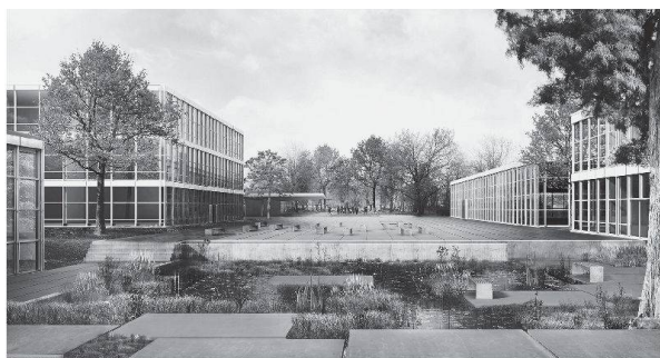
Grosszügiger Freiraum: Armin Benz Martin Engeler Architekten.
