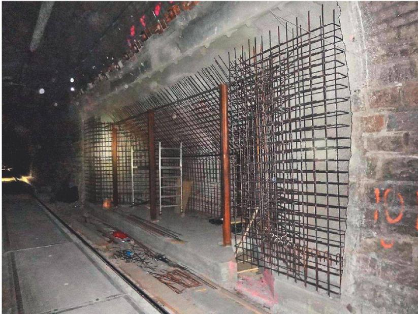
Für das Erstellen der Muffen der Hochspannungskabel werden alle rund 1500 m Nischen benötigt (Länge: 12 m, Tiefe: 2 m, Höhen bis zu 3.5 m). Diese Muffennischen werden seitlich längs der Tunnelröhren angeordnet und im Sprengverfahren ausgebrochen.
