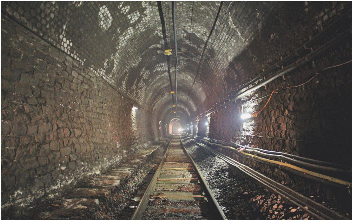
Der Simplontunnel ist **das einzige grosse Tunnelbauwerk aus der Pionierzeit der Eisenbahn, das Bestandteil der Neuen Alpentransversalen ist**. Bei der Aufrüstung der über 100 Jahre alten Anlage sind viele Kompromisse notwendig, wie zum Beispiel die Sonderwerte des Lichtraumprofils.
