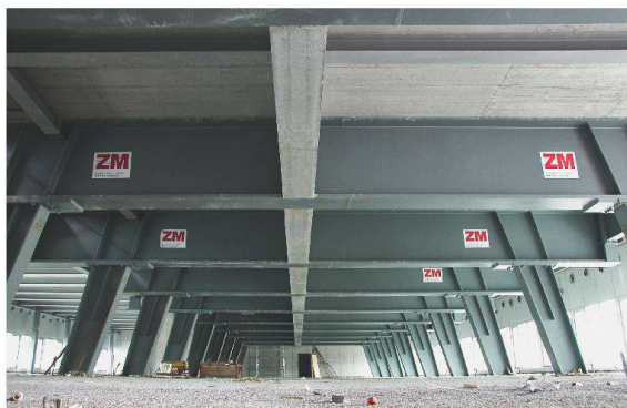
Abfangtisch: Das Raster von 5 \times 12.5 m im bestehenden Trockenwerk ist für den Wohnungsbau, der oben aufgestockt wurde, nicht optimal. Ein Zwischengeschoss mit einem Trägerrost aus Stahl bildet den Wechsel (vgl. Schnitt oben).
