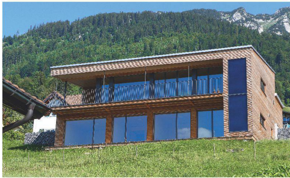
Plusenergie-Ferienhaus in Amden, Energiebezugsfläche 176 m 2
