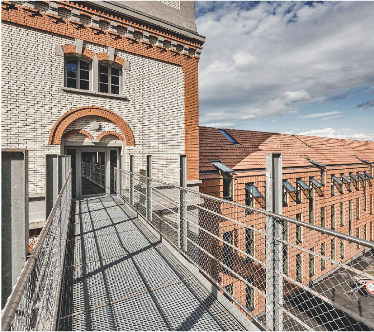
Gurtenareal in Bern: Blick auf das ehemalige Sudhaus in der Mittelzeile des Ensembles, rechts ein angefügter Neubau.
