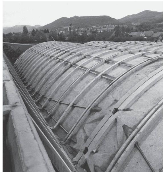
Bei einer Umnutzung wurde das VSK-Dach mit modernen Berechnungsmethoden nachgerechnet. Als Zeugnis der Präzision der Modellstatik stellte sich heraus, dass **kein Eisen zu viel, aber auch keines zu wenig eingelegt** wurde.
