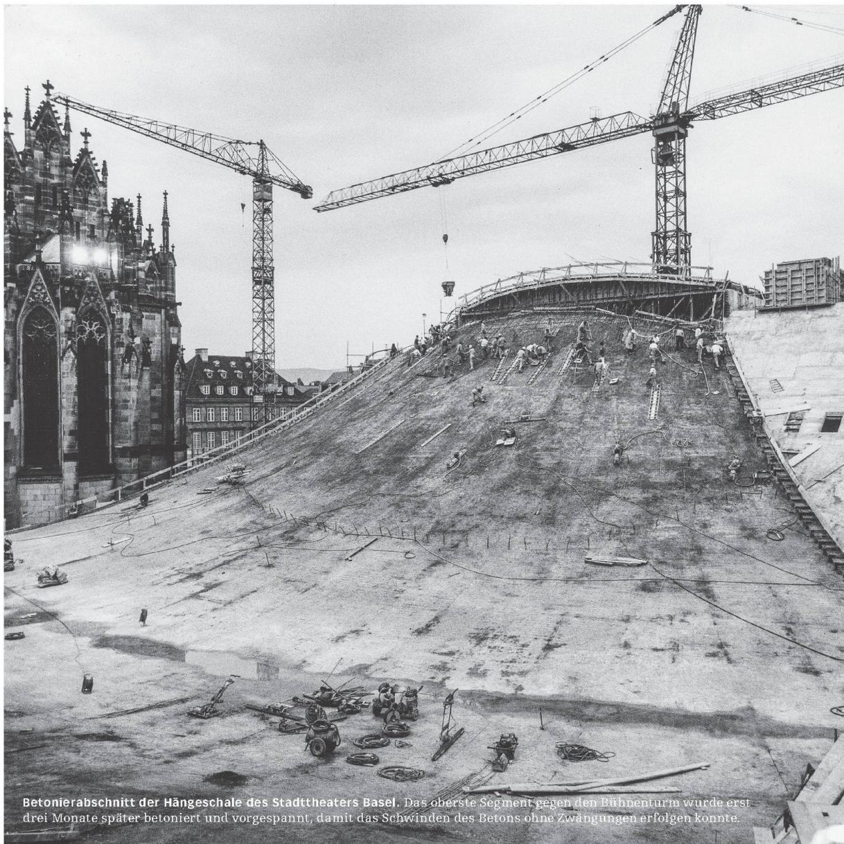
Betonierabschnitt der Hängeschale des Stadttheaters Basel. Das oberste Segment gegen den Bühnenturm wurde erst drei Monate später betonierte und vorgespannt, damit das Schwinden des Betons ohne Zwängungen erfolgen konnte.
