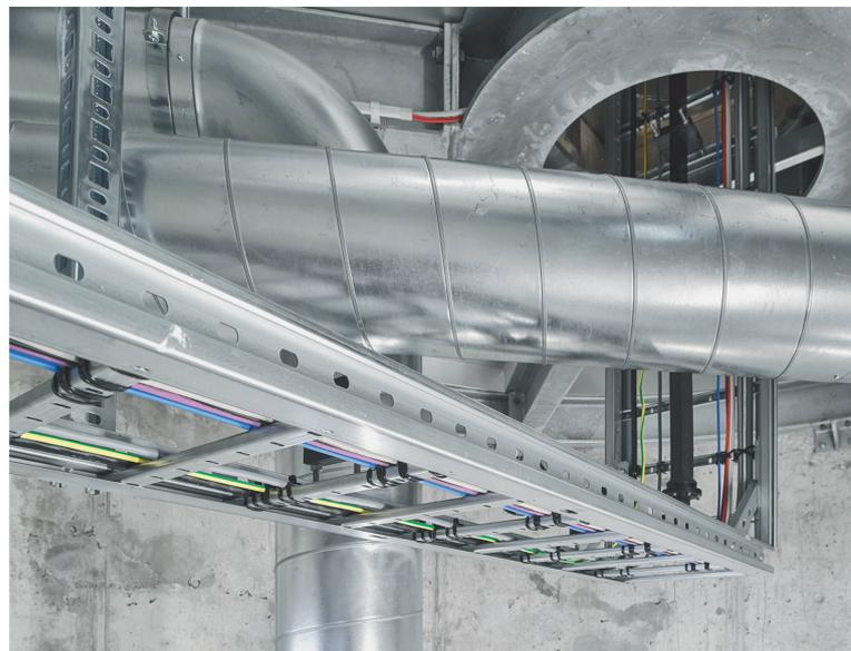
**In der Radarstation haben die Handwerker ihre Visitenkarte hinterlassen:** Die Kabel sind schön sichtbar und sauber getrennt verlegt. In regelmässigen Abständen sind sie mit über Kreuz gewickelten Kabelbindern befestigt.
