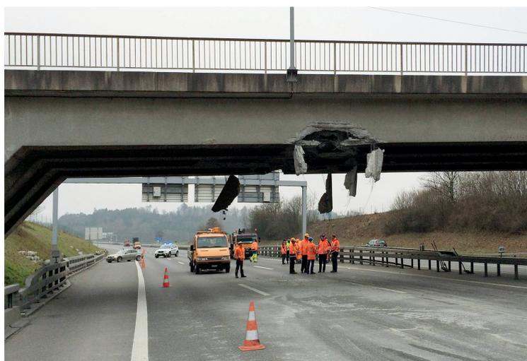
Im vergangenen Januar rammte ein zu hoch beladener Lastwagen die A1-Überführung bei Birmenstorf. Nun wird die beschädigte Brücke abgerissen.
