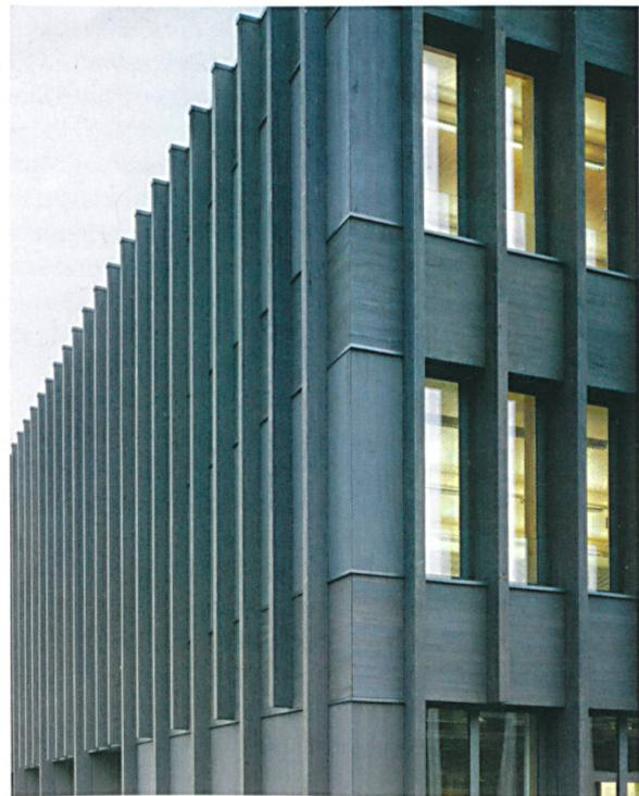
**Rippenfassade des Erweiterungstrakts am Gymnasium Strandboden:** Der Grundraster 2×2 m gilt für Gestaltung und Tragwerk (vgl. Grundriss oben: Stützen rot gekennzeichnet).
