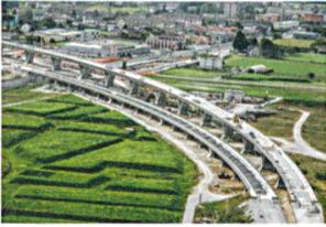
Der einspurige, ans Nordportal anschliessende Bahnviadukt, auf dem die Züge Richtung Norden fahren werden, verbindet den Ceneri-Basistunnel mit der SBB-Linie zwischen Bellinzona und Locarno (vgl. TEC21 41/2008, «Monte Ceneri»).
