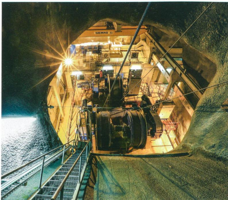
Arbeiten am Gotthard-Basistunnel: Blick in den Schrägschacht, der die Windenkammer mit der Schachtglocke verbindet.
