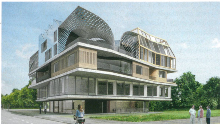
Das Pilot- und Demonstrationsprojekt NEST der Empa testet neue Materialien und Systeme auf ihre Markttauglichkeit.
