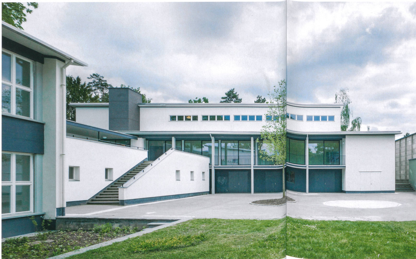
Treppenaufgang zum Seiteneingang der Schule (links) und der ehemaligen Turnhalle (rechts), die jetzt die Aula beherbergt. Die neuen Glasschiebefenster sind in den Rhythmus des Bestands eingepasst und lassen sich auf der gesamten Länge zum Vorplatz hin öffnen.
