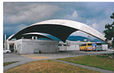
Oben: Isler-Hängeschale im Bauzustand (Hallenschwimmbad Brugg, 1981).
