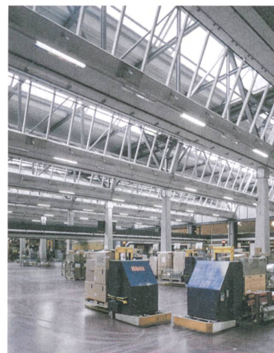
Ein korrosionsanfälliges Sheddach: Querschnitt Verteilzentrum Wangen, Mst. 1:500 (links) und Innenansicht (rechts). Das ursprüngliche Sheddach wurde 1997 auf eine neue Stahlkonstruktion aufgehängt und entlastet. Die Shedelemente samt externer Vorspannung – das besondere Merkmal der Konstruktion – werden schrittweise ausgebaut.
