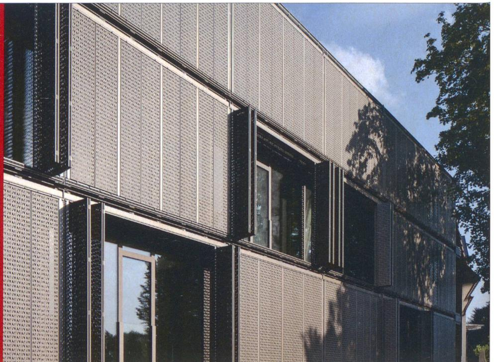
Das automatisierte Beschlagsystem für frontbündige Faltschiebeläden HAWA-Frontego 30/matic bietet individuellen Sicht- und Sonnenschutz und gleichzeitig mehr Sicherheit. Der energiesparende Antrieb und die Steuerung sind im System integriert.
