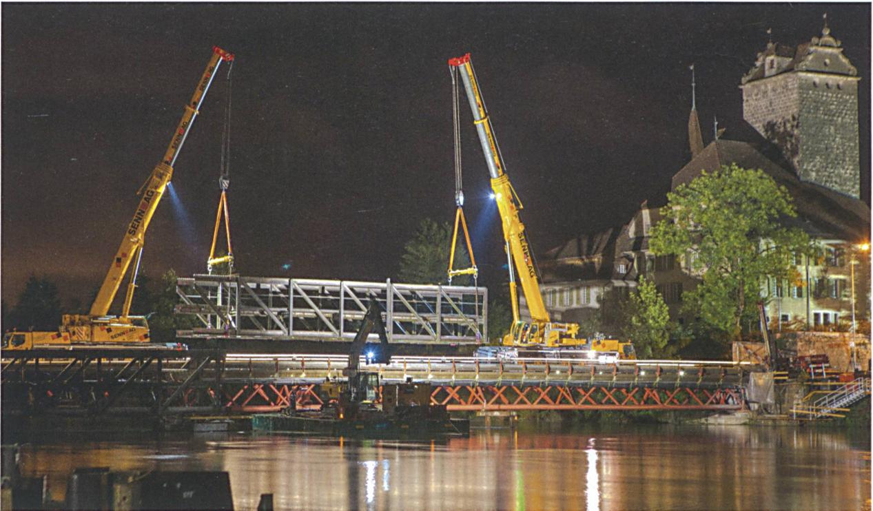
Die bestehende Bahnbrücke wird in vier Segmenten und vier Nachtschichten von der benachbarten Strassenbrücke aus rückgebaut, quasi ohne Hilfsgerüste. Die Montage der neuen Bahnbrücke erfolgt in der genau umgekehrten Reihenfolge.
