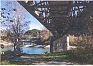
Der historischen Hinterrheinbrücke im bündnerischen Reichenau soll eine zweite Eisenbahnbrücke zur Seite gestellt werden, um die instandsetzungsbedürftige Konstruktion zu entlasten.
