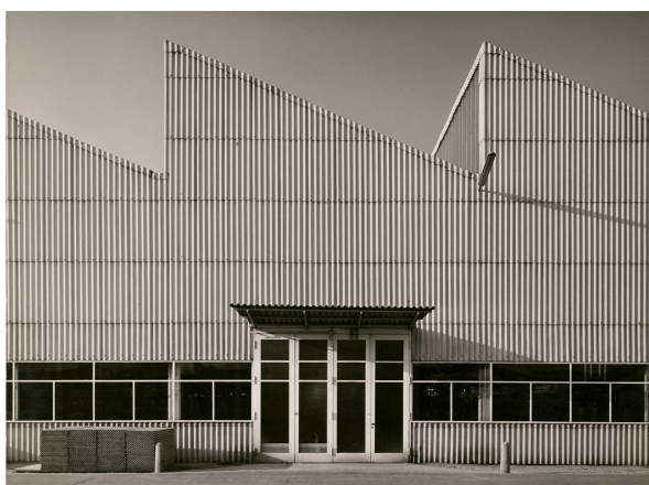
Eternitverkleidet: die Südseite des Eternit-Werks in Leimen.
