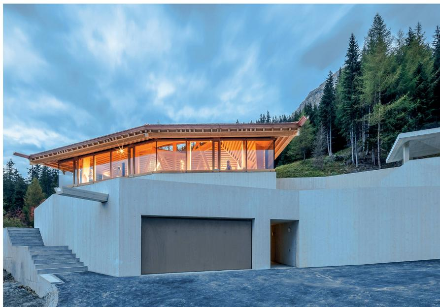
Ansicht von unten: **Massive Stützmauern aus weissem Beton** prägen die äussere Erscheinung des untersten und des mittleren Geschosses, darüber erhebt sich der **hölzerne Aufbau des Wohnraums**. In Wirklichkeit greifen die untere Beton- und die obere Holzkonstruktion bereits im mittleren Geschoss ineinander: Deren Fassade ist aus Beton, die innere Konstruktion jedoch aus Holz.
