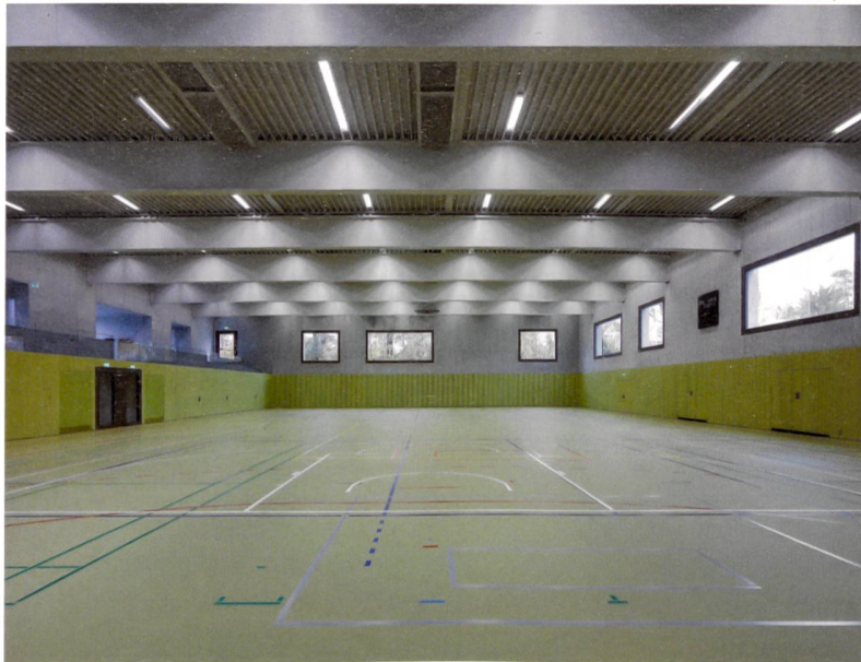
Im Hallenraum harmoniert der graue Sichtbeton mit den zurückhaltenden Farben der Holzlattung, die als Akustikverkleidung dient.
