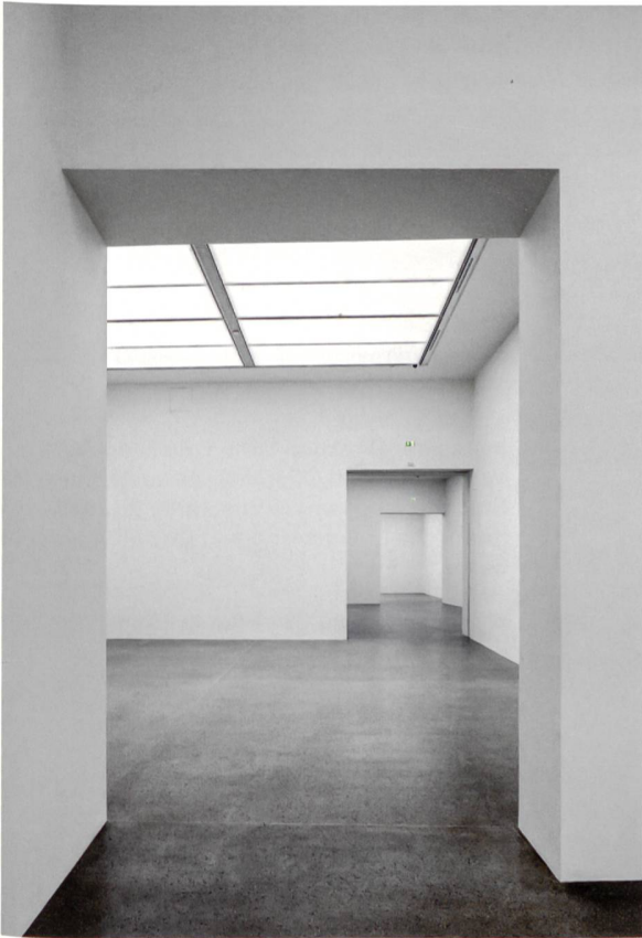
Die «tanzenden Räume» werden durch Wände umfasst, die zwar in einen orthogonalen Grundrissraster eingefügt, jedoch durch den Innenausbau jeweils um ein paar Grad gegeneinander versetzt sind.
