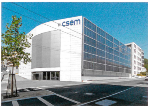
Nach der Instandsetzung: Die postmoderne Hauptfront mit dem Logo auf der Westseite blieb weitgehend unverändert. Neu ist die Fassade mit den PV-Elementen, die vor die bestehende Südwand gestellt wurde. Sie vereinheitlicht die Höhe des Baus und rückt ihn in die Strassenflucht.
