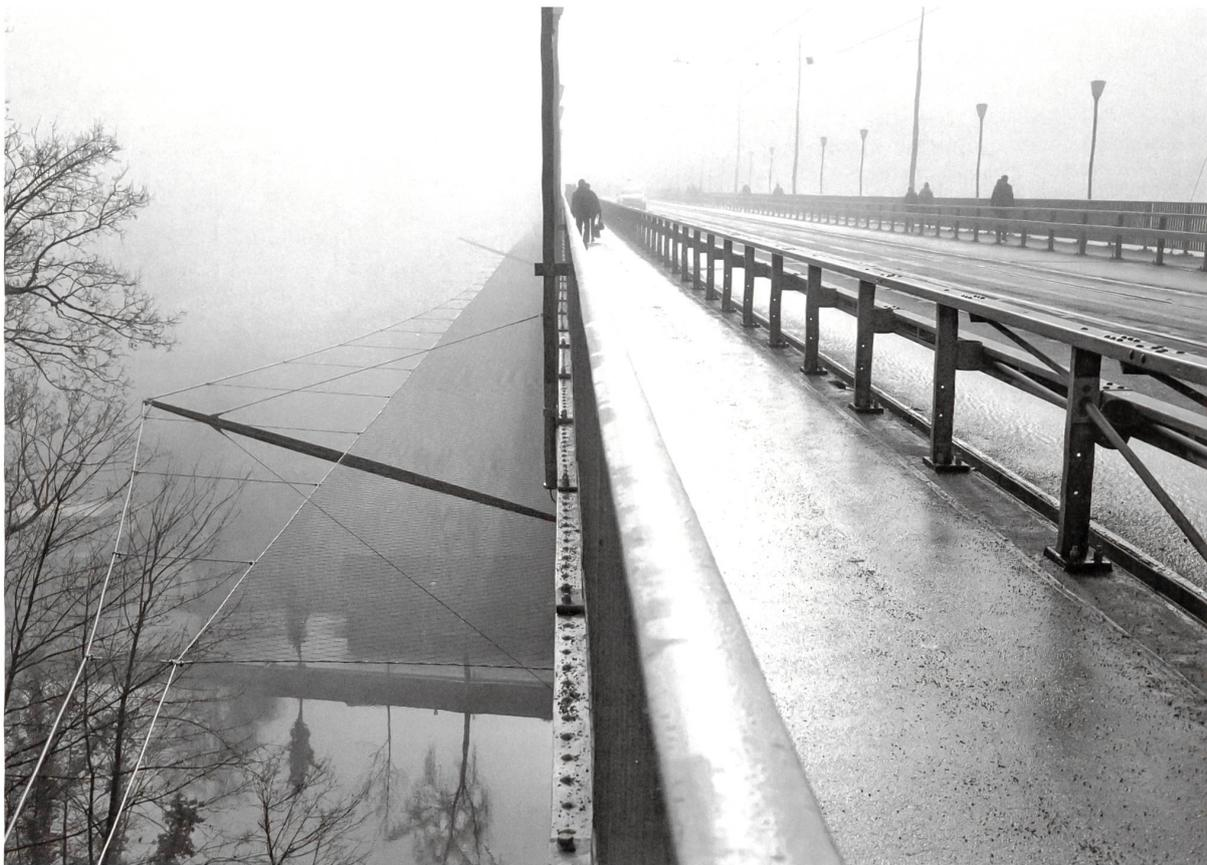
**Das Fangnetz an der Kirchenfeldbrücke als kontinuierliches Band:** Im weitmaschigen Edelstahlseilnetz (Maschen:  $180 \times 313$  mm; 3 mm Drahtseile) sind die Maschen hülsenlos zusammengeflochten. Einzelne Netzteile (parabelförmiges Schnittmuster) sind mit Verpresshülsen auf der Baustelle zusammengefügt worden und können künftig ausgetauscht werden.
