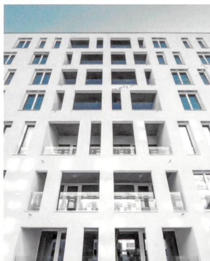
Insgesamt wurden 831 Fenster und Fenstertüren in Standard- und Spezialgrössen montiert. Deren hochdämmende Mehrkammer-Geometrie mit einem U-Wert bei 0,7 W/m<sup>2</sup>K und einem Schallschutzwert bei 38 dB entspricht dem geforderten ökologischen Standard, die 25-mm-Schwellen machen die Fenstertüren behindertengerecht.
